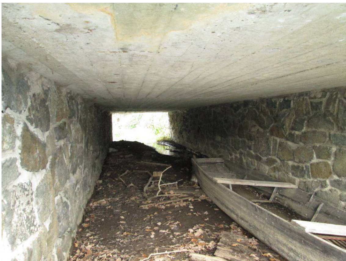
Pohled pod most. Lok. odpadlé krytí, průsaky, nánosy.
