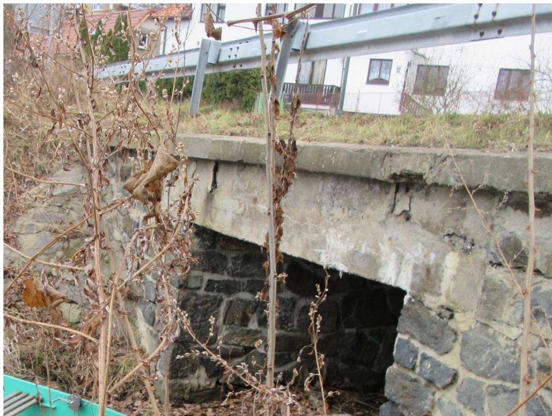
Bok NK - odpadlé krytí, výluhy. Lok. odpadlá spodní hrana římsy.
